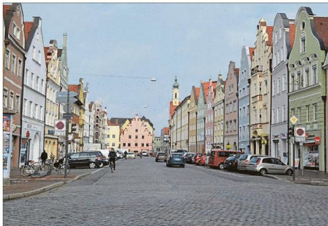
In diesem Jahr wird damit begonnen, die Innenstadt zu erschließen: Von der Podewilsstraße geht es über den Alten Viehmarkt in die Neustadt und Gassen.
