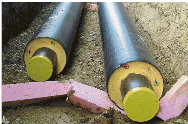
Die Stadtwerke bauen seit einigen Jahren ihr Fernwärmenetz aus.
