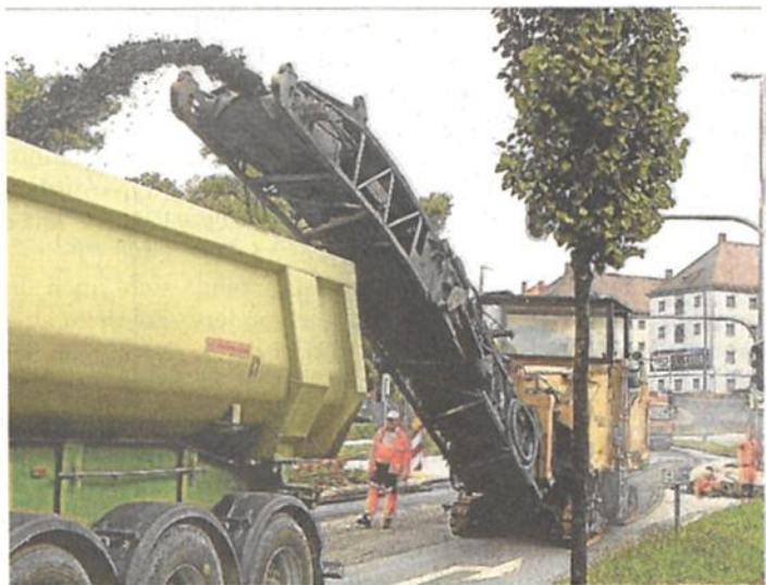
Bis heute soll die Sanierung der Straßen auf der Seite der Parkhäuser, der Einfahrt zum Hofbergtunnel und der Gewerbebetriebe fertig sein. Bis Samstag folgt die andere. Foto: rüd
